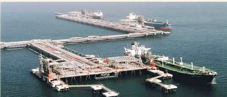
الرصيف الجنوبي في مصفاة الأحمدى
